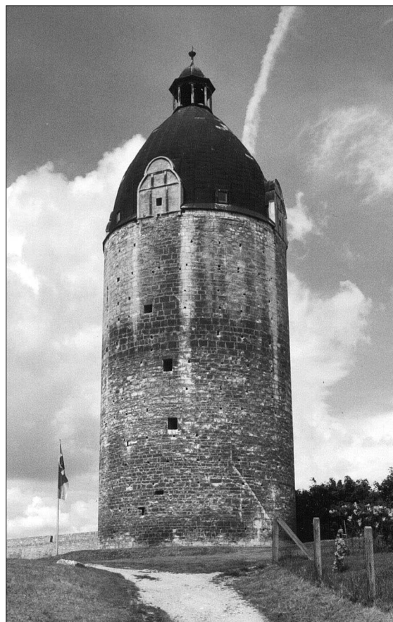
Neuenburg. Wohnturm „Dicker Wilhelm“ in der zweiten Vorburg.
