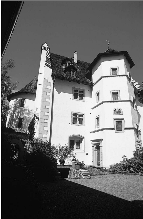
Eigeltingen: Schloß Hegi nach der Rekonstruktion. Aufnahme AG Hegau und Schaffhausen, Foto: Hans Noll 2001.
