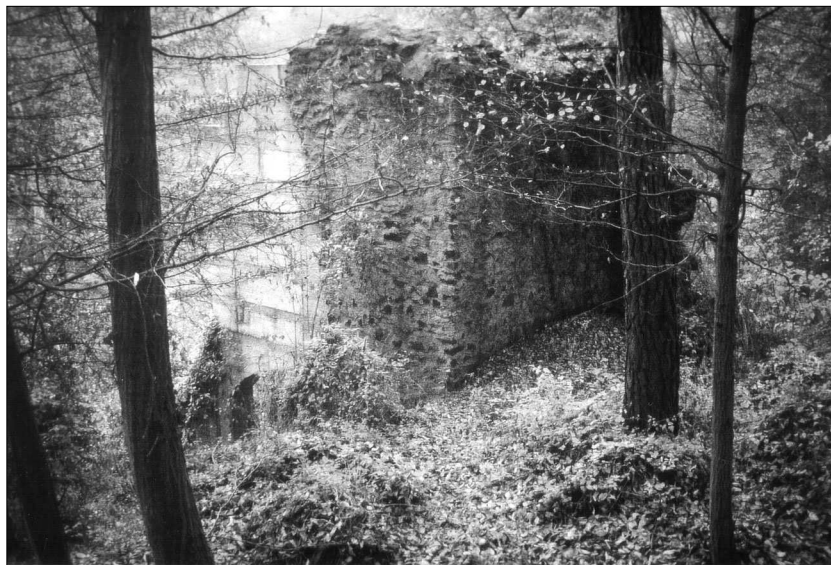
Abb. 2: Neu-Elkerhausen, Turmstumpf oberhalb des Halsgrabens.
