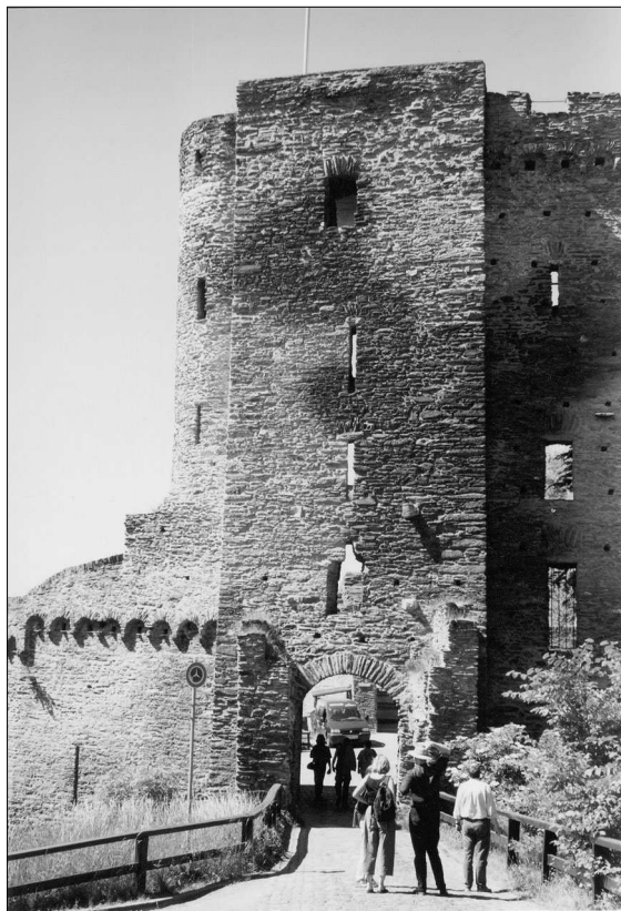
Burg Hohenstein, Stammsitz der Katzenelnbogener. Mantelmauer mit turmartigem Vorbau und Haupttor als Zugang zur Vorburg.
