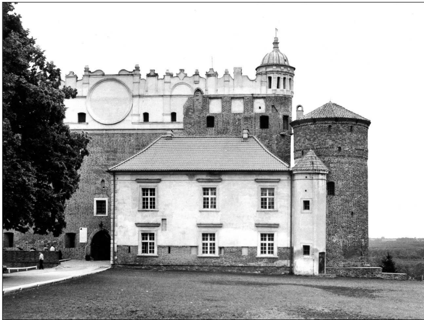
Abb 13: Gollub/Golub. Teil der Westfassade mit Einfahrtstor und Bergfried. Zustand 2000. Foto Verfasser.
