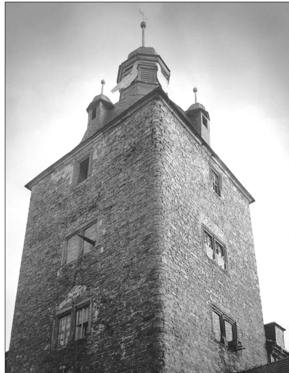
Abb. 2: Hundisburg (Landkreis Ohrekreis), Bergfried von Südwesten (1954).
